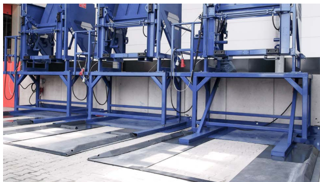
Installation à quai de lève-conteneurs fixes
