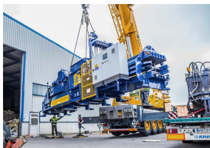
Installation d'une machine AVOS 1810 B5-90/100
