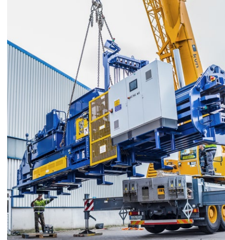
Installation einer AVOS 1810 B5-90/100
