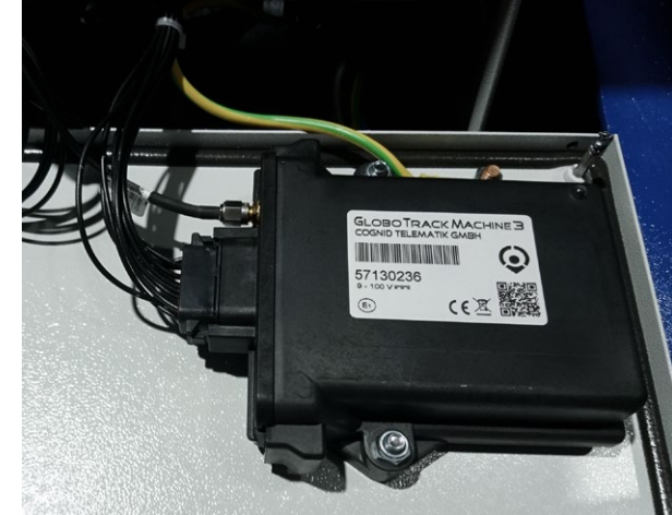
Einbau GTM auf dem Deckel des Schaltkastens und Verbindung über Stecker mit der Avermann Platine
