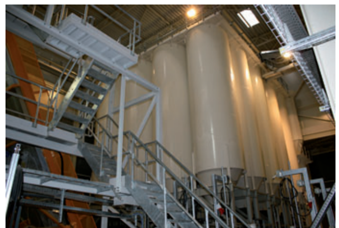
Verteilung der Zuschlagstoffe in die 24 Silos
