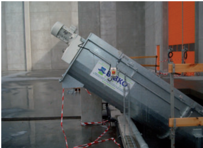
RWS-Abwurf (während Montage)
