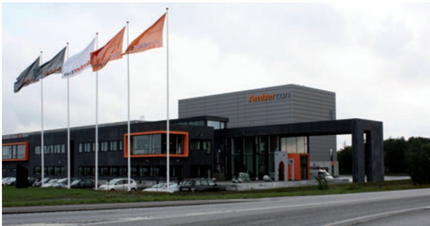
Bei der Firma Ambercon in Dänemark wurde eine der größten Kipptischproduktionsanlagen Europas in Betrieb genommen
