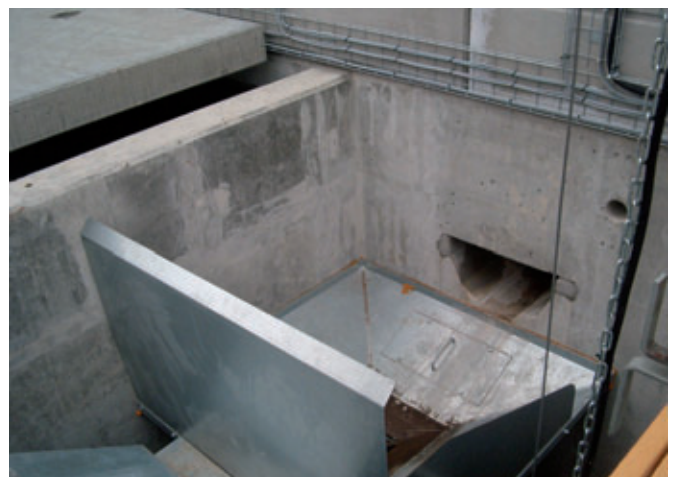
Übergabebereich Rinne zur RWS-Anlage
