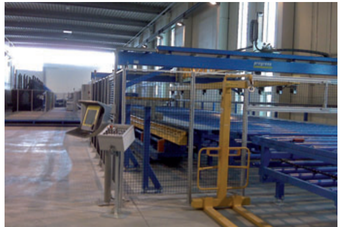
Auf der Mattenschweißanlage können Matten mit Abmessungen von bis zu 6m x 12m produziert werden
