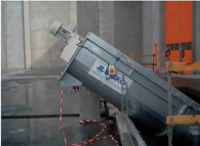
Descarga RWS (durante el montaje)
