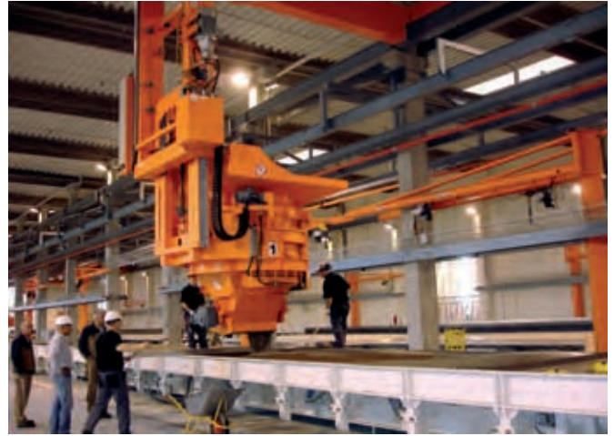
Primer hormigonado durante la fiesta de inauguración en 8-8-2008 a las 8:08 horas.
