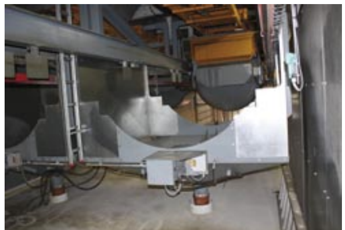
Stanowisko czyszczenia wózków betonu.
