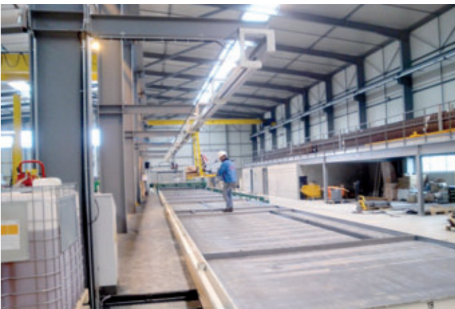
Manuelle Schalplätze mit Arbeitsplatzsystem
