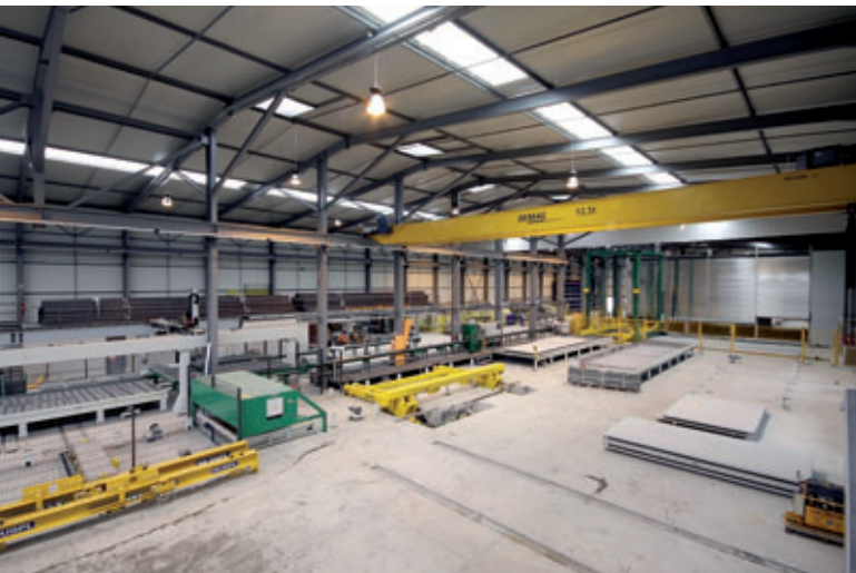
Anlagenübersicht Entschalbereich mit Kippstation
