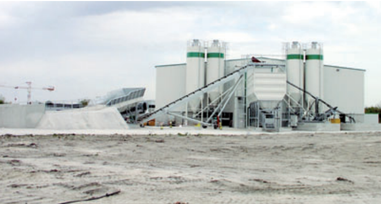
Neue Produktionshalle in St. Jean d'Ilac
