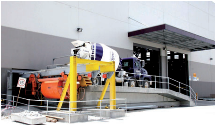
Kübelbahnbefüllung durch Transportmischer
