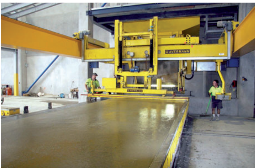
Betonverteiler mit Glättbohle
