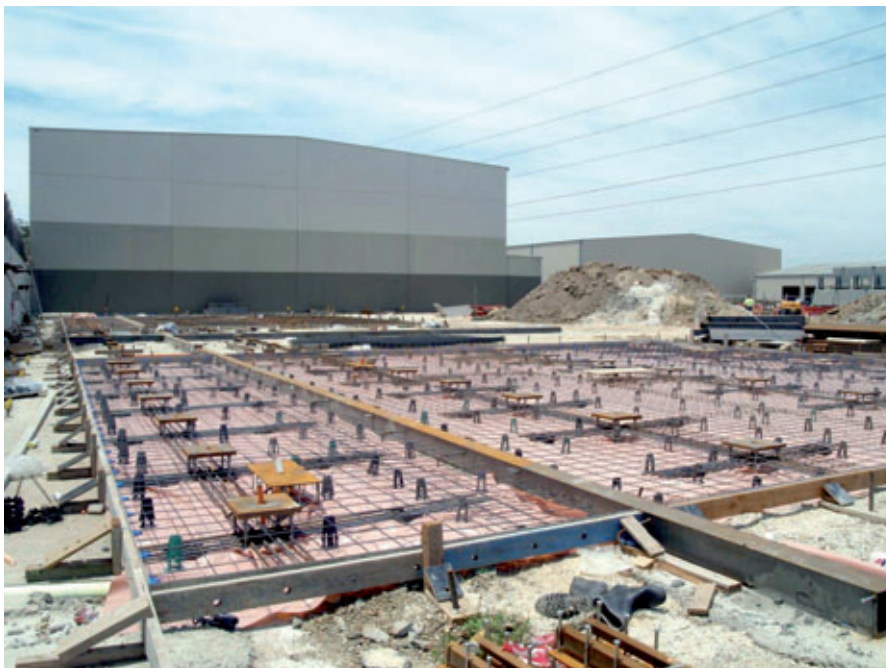
Gründungsarbeiten für die neue Halle
