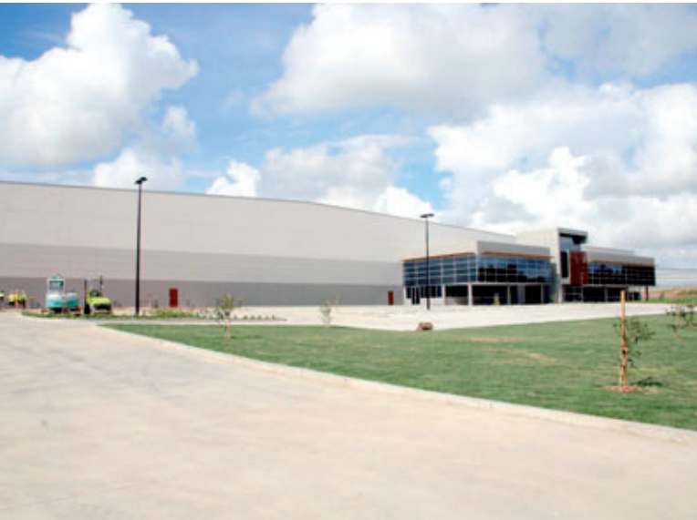
Beispiel einer Gewerbehalle aus Fertigteilen geliefert und montiert von Sasso
