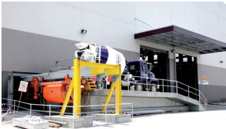
Le remplissage du convoyeur à bennes par des camions malaxeurs
