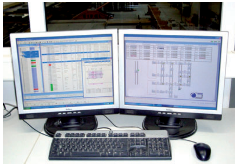
Poste de contrôle SAA
