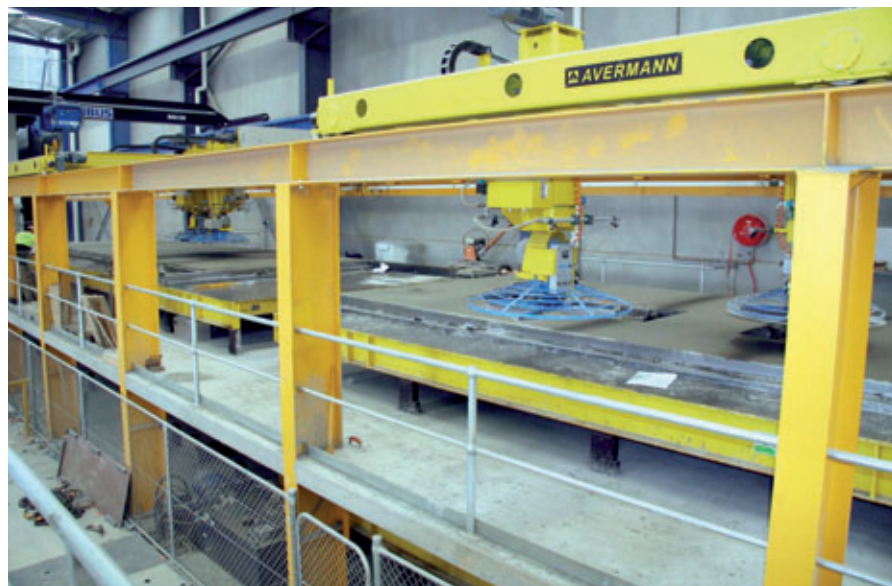
La station de lissage avec dispositifs de lissage à pales
