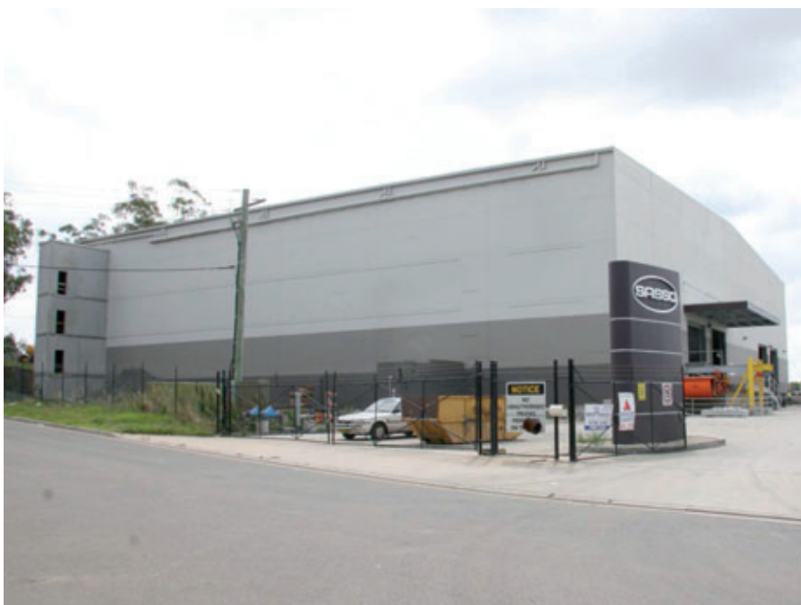
Le nouveau hall de production
