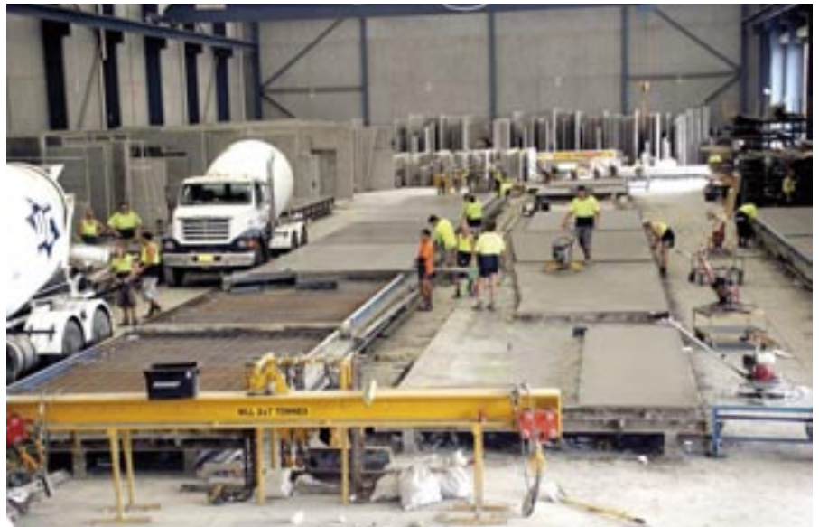
Wygląd starej hali produkcyjnej.
