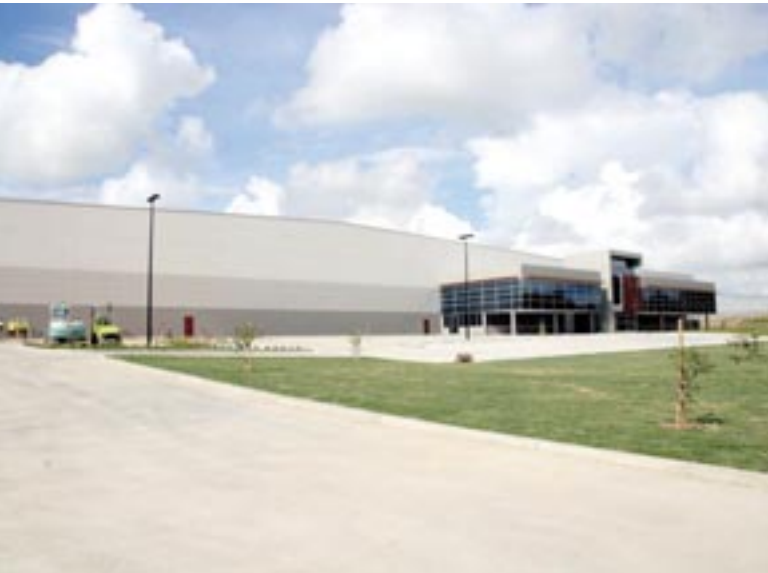
Przykład hali komercyjnej wybudowanej przez Sasso z prefabrykatów własnej produkcji.
