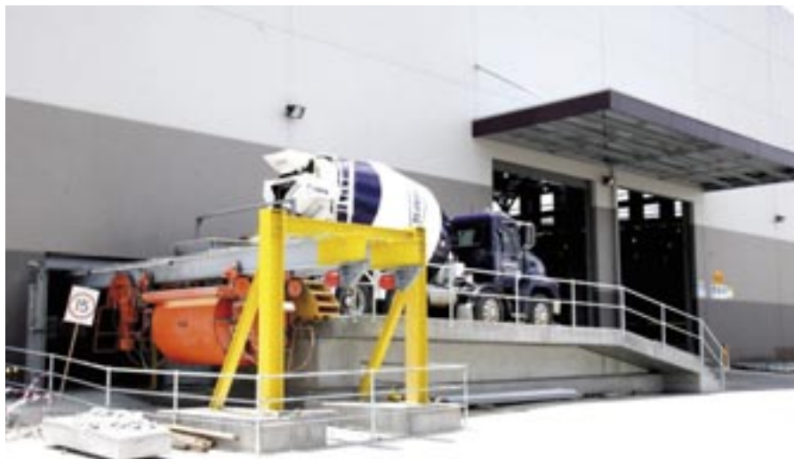
Napełnianie wózka betonu z betoniarki samochodowej.
