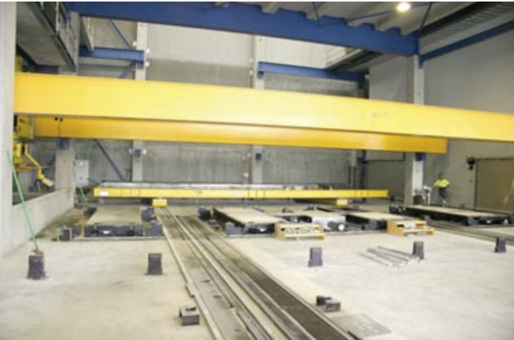
Przejazd poprzeczny pod rozścielaczem mieszanki betonowej i zagęszczaczem wibracyjnym.
