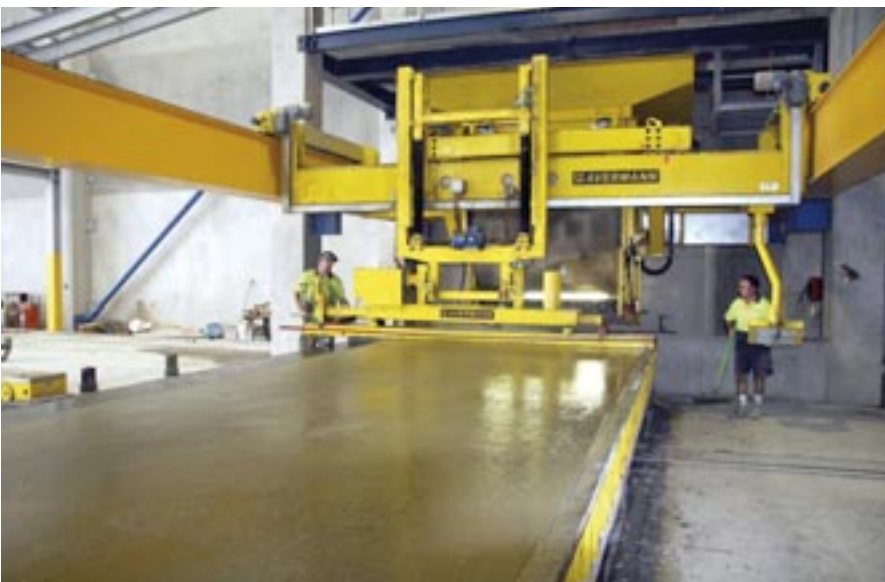
Rozścielacz mieszanki betonowej z listwą wygładzającą.
