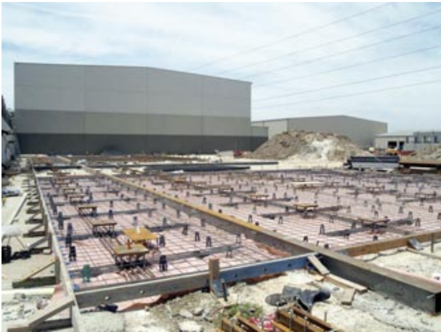
Budowa fundamentu pod nową halę.
