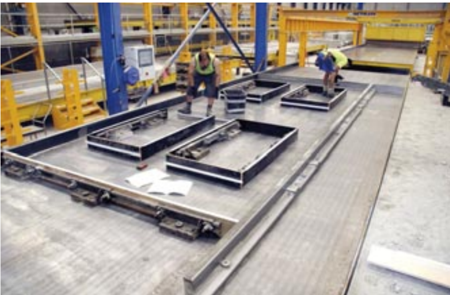
Stanowisko ręcznego szalowania.
