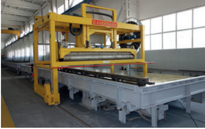
Vue sur l'un des deux halls de production, équipé d'une machine de lissage et de tables basculantes
