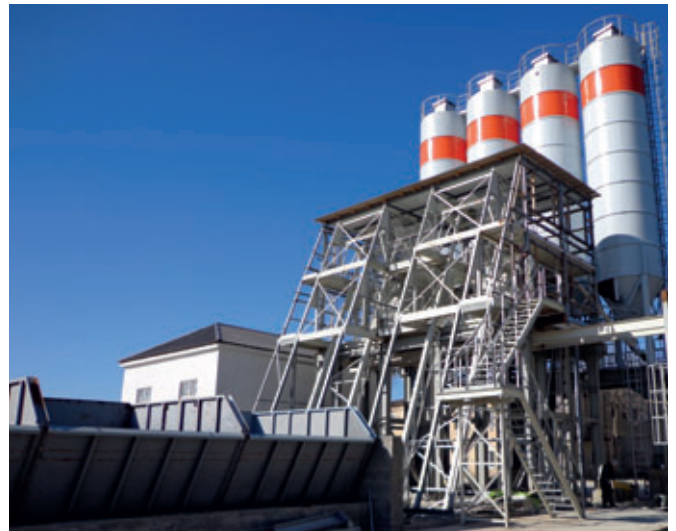
Centrale à béton Teka au cours de sa phase de montage
