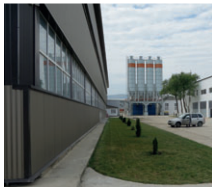
Vue sur la façade du bâtiment avec la centrale à béton située à proximité
