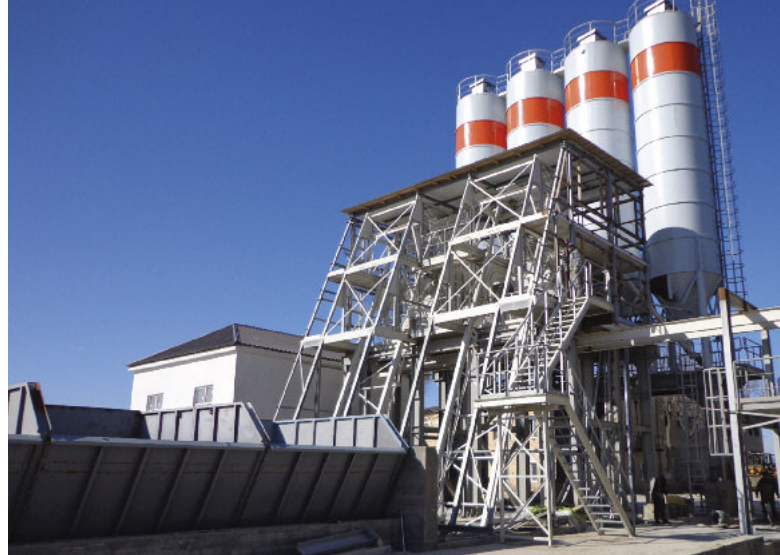
Węzeł betoniarSKI Teka w trakcie rozbudowy.
