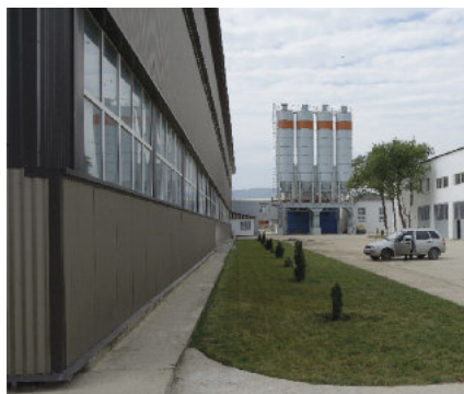
Widok na fasadę budynku wraz ze stojącym obok węzłem betoniarskim.
