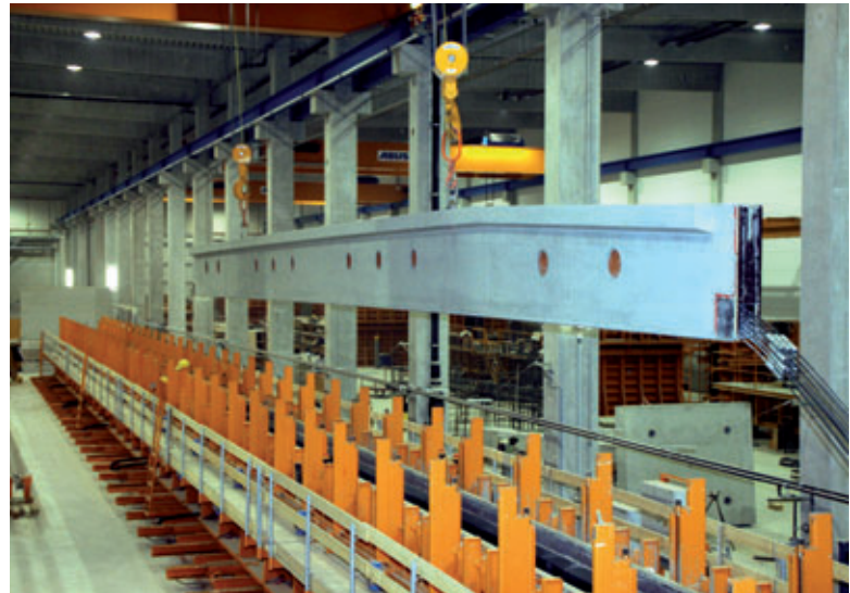
Levage d'une poutre de toiture à deux versants
