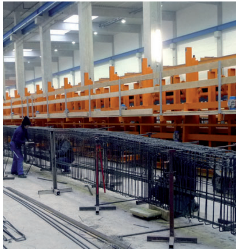
Fabrication de la cage d'armature
