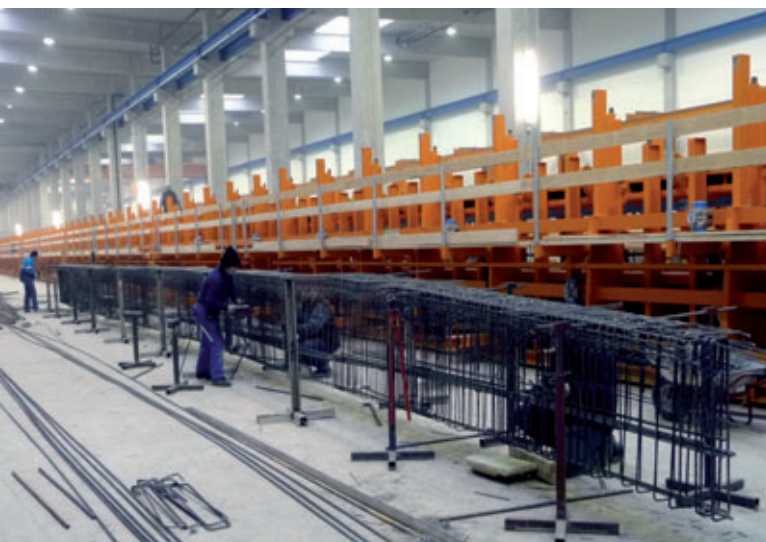
Herstellung des Bewehrungskorbes
