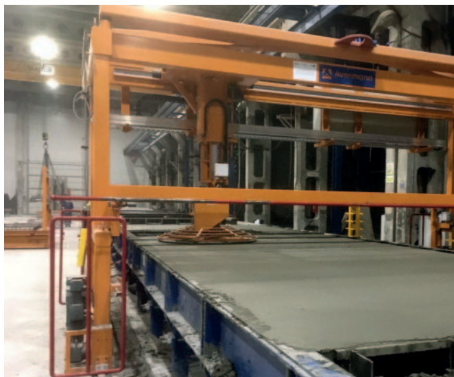
Lissage des éléments par une truelle mécanique
