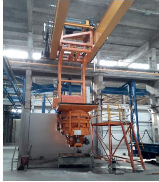
Distribuidor de hormigón en el momento de acoplarse a a grúa
