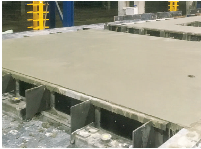
Pieza de hormigón alisada
