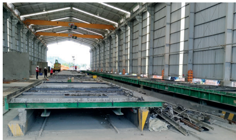
In der Produktionshalle sind 16 Kipptische in zwei parallel zueinander verlaufenden Linien angeordnet.
