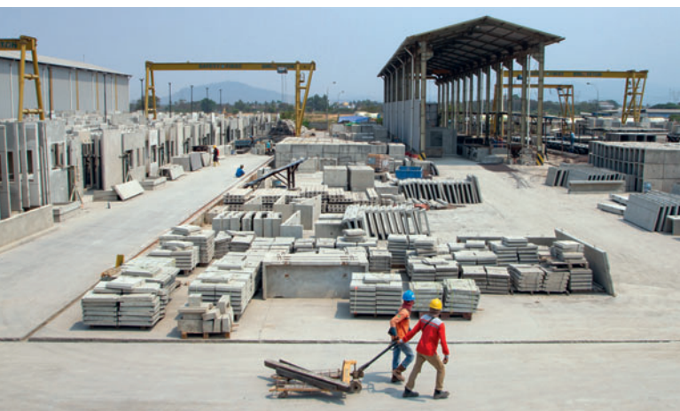
Blick vom Balkon des Verwaltungsgebäudes auf das 38 ha große Firmengelände von PT Motive Mulia, auf dem das Werk derzeit 5 ha einnimmt; links ist die Außenwand der Produktionshalle mit der Kipptischfertigung von Avermann zu sehen.
