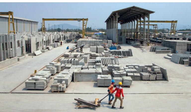
Widok z balkonu budynku biurowego na 38 ha terenu zakładowego PT Motive Mulia. Obecnie hala zajmuje powierzchnię 5 ha. Z lewej strony widać ścianę zewnętrzną hali, w której zamontowano stoły uchylnie firmy Avermann.
