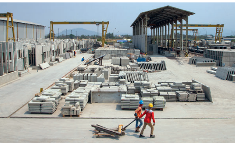
Vue depuis le balcon du bâtiment administratif sur le site de PT Motive Mulia de 38 hectares, où l'usine occupe actuellement 5 hectares; à gauche, on peut voir le mur extérieur de la halle de production qui abrite la ligne de fabrication sur tables basculantes conçue par Avermann.
