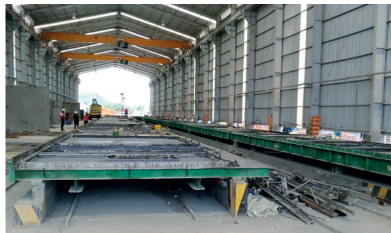
Dans la halle de production, 16 tables basculantes sont disposées sur deux lignes parallèles.
