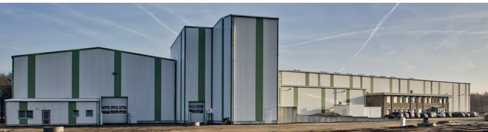
Außenansicht des neuen Betonwerks am Standort Holdorf
