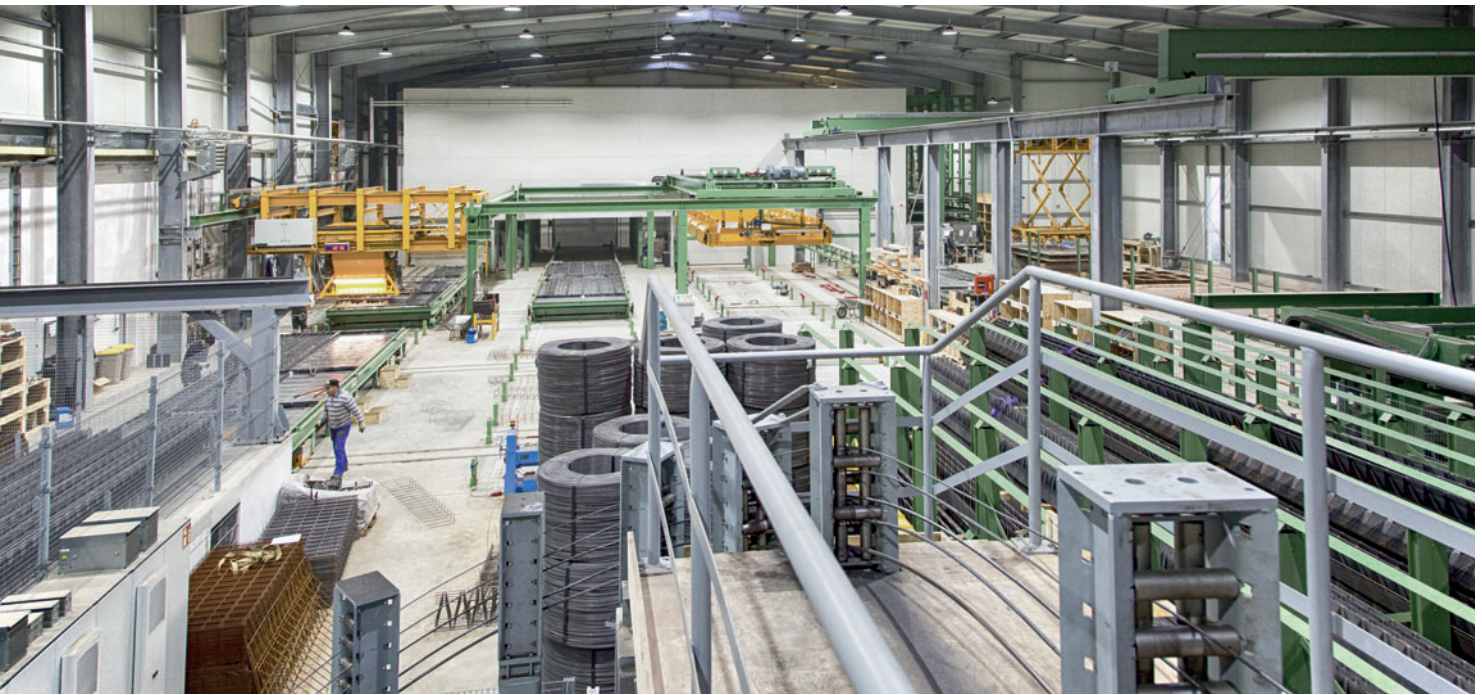
Umlaufanlage Bereich Betonieren/Verdichten, Wenden und Abhebestation
