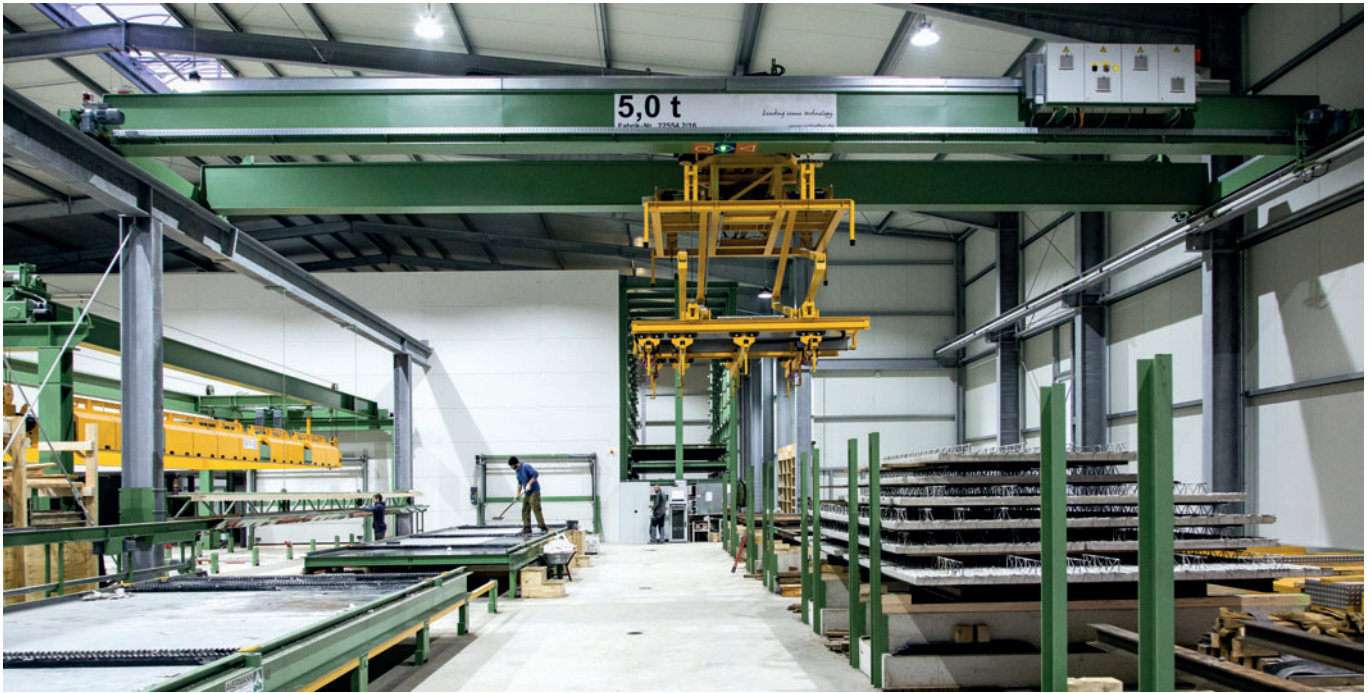
Grúa especial para elevar las losas
