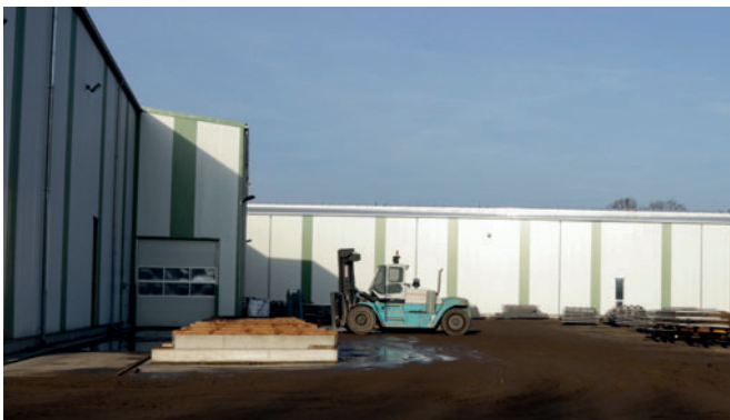
Zona exterior: Carro de salida y lugar de almacenamiento
