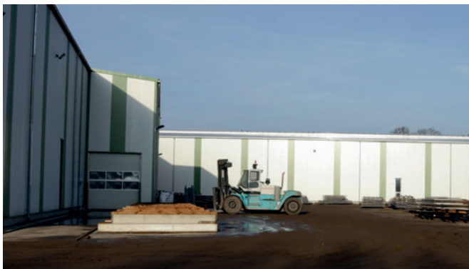
Zone extérieure : chariot de transfert et emplacement de stockage
