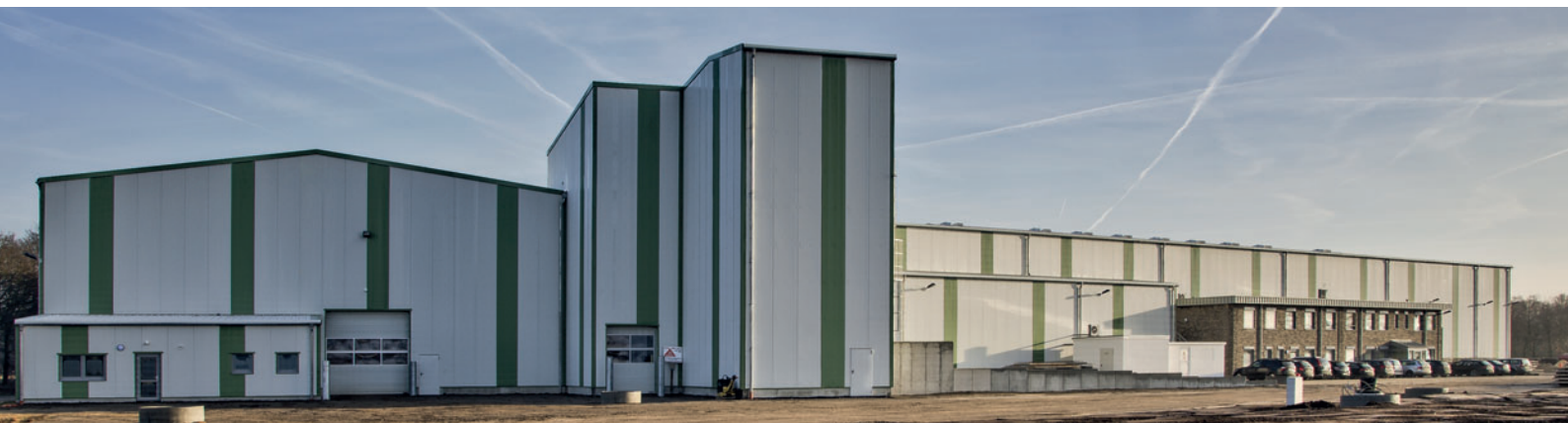
Vue extérieure de la nouvelle fabrique de béton sur le site de Holdorf
