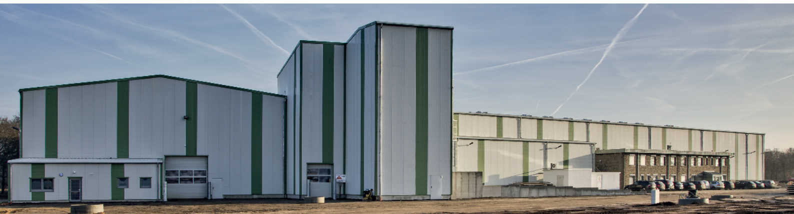
Wygląd nowego zakładu betonowego w Holdorf.
