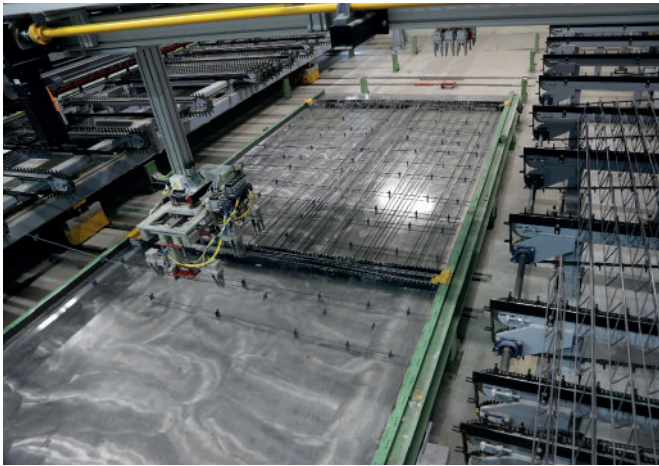
W pełni zautomatyzowane stanowisko układania zbrojenia z robotem austriackiej firmy EVG.
