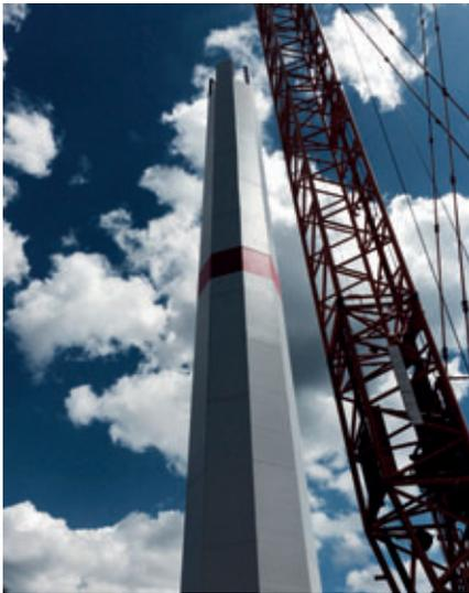
Fig. 1: Torre híbrida Ventur patentada para aerogeneradores
