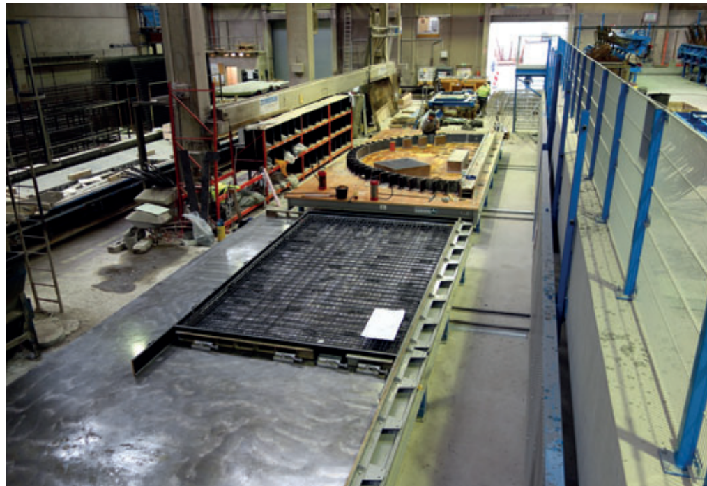
Fig. 5 : stations de coffrage et d'armature pour les éléments massifs / sandwich et spéciaux
