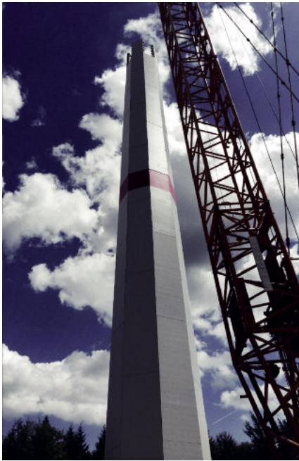
Opatentowana wieża hybrydowa Ventur dla elektrowni wiatrowych.
