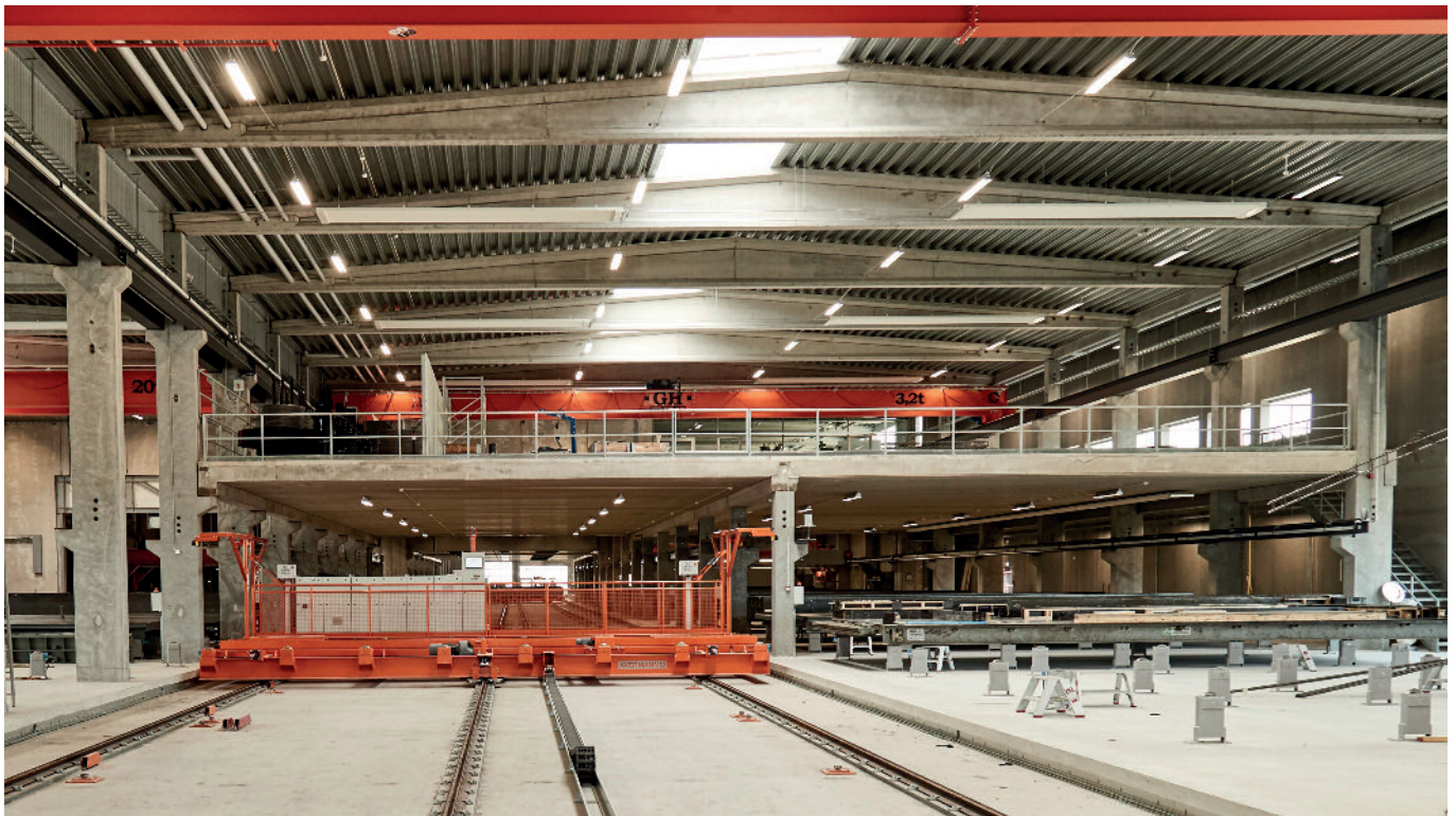
3. Transport podkładów za pomocą centralnej platformy szynowej.
