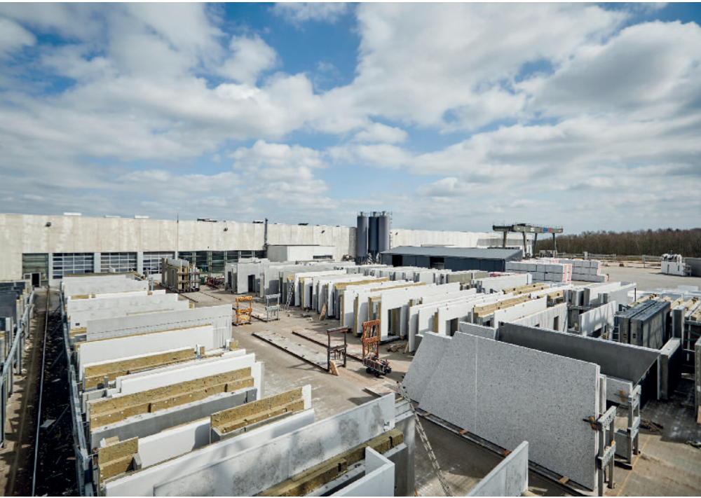
2. Widok na plac składowy i obie hale produkcyjne z węzłem betoniarskim pośrodku.
