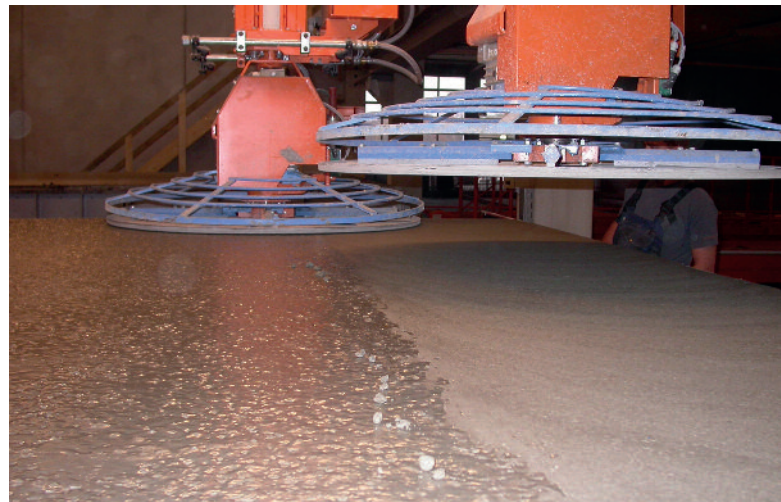
6. Wygładzanie powierzchni elementów betonowych.
